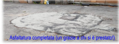
Asfaltatura del cortile sopra la botola raccolta acque
